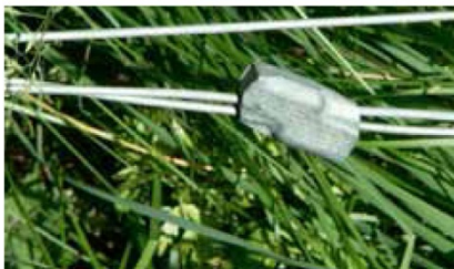
Bild 3. Spänn trådarna hårt med trådspännare eller gripplar. Gripplar är billigast.
